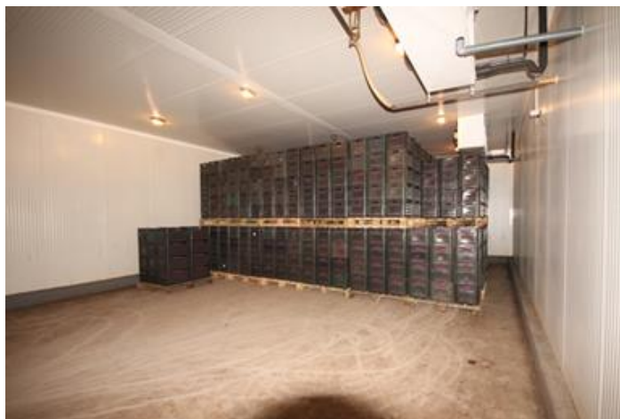
сл.2 Расхладна комора у хладњачи „Моровић“
